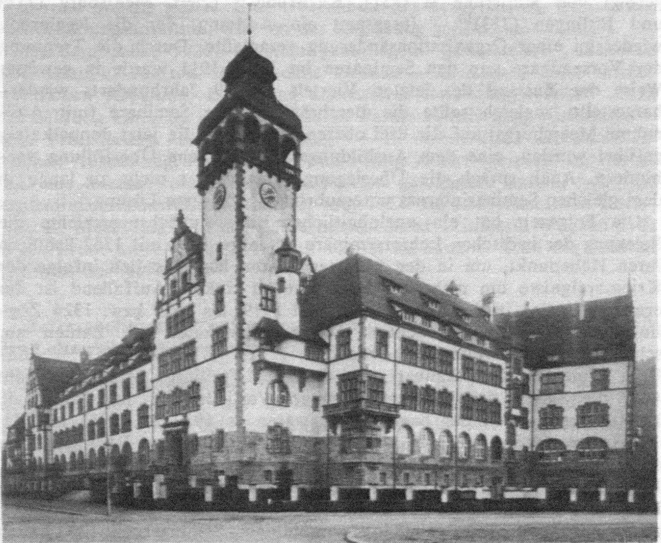
Abb. 1: Gebäude des 1907 errichteten Lehrerseminars Freiburg in der Schützenallee, jetziges Lycée Tyrenne.
