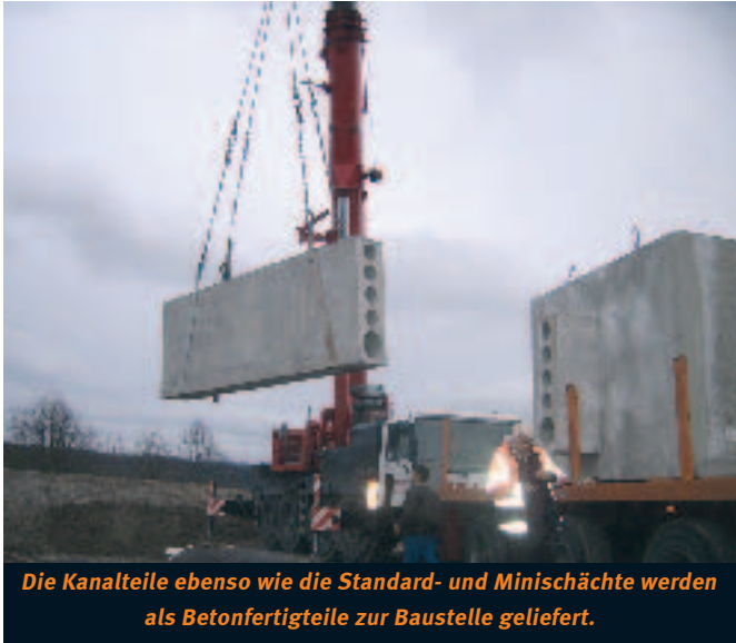
Die Verlegung der Betonelemente erfolgt auf der Baustelle mit den üblichen Geräten und Methoden des Kanalbaus.
