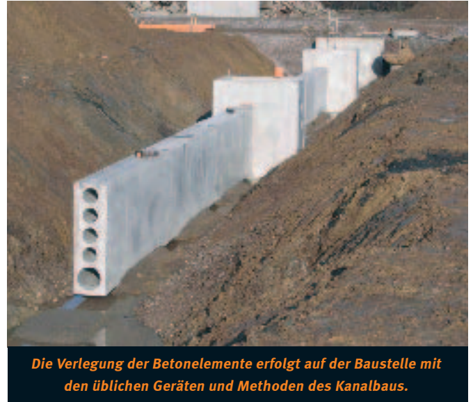
Die Kanalteile ebenso wie die Standard- und Minischächte werden als Betonfertigteile zur Baustelle geliefert.
