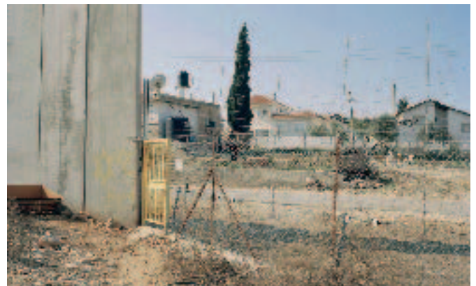
Sperranlage zwischen Israel und Palästina beim Ort Masha in der Westbank
