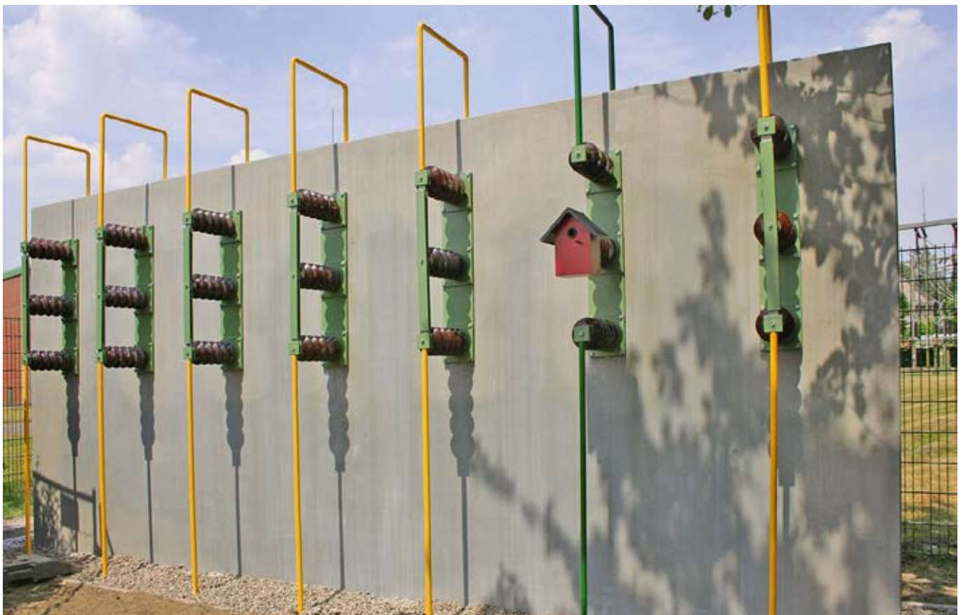
Marcel Pörtner: „Offline“ Umspannanlagen sind die Knotenpunkte der Energieverteilung. Die Installation von Marcel Pörtner greift mit Rohren, Isolatoren und Stahlteilen die formalen Elemente der Hochspannungstechnik auf. Mitten im Schaltersystem, das in Fröndenberg aufgebaut ist, etwas Unerwartetes – ein Vogelhäuschen. Hier wird der Stromfluss unterbrochen, geht „offline“. Inspiriert wurde der Objektdesigner durch die Vogelschutzmaßnahmen des Stromkonzerns.
