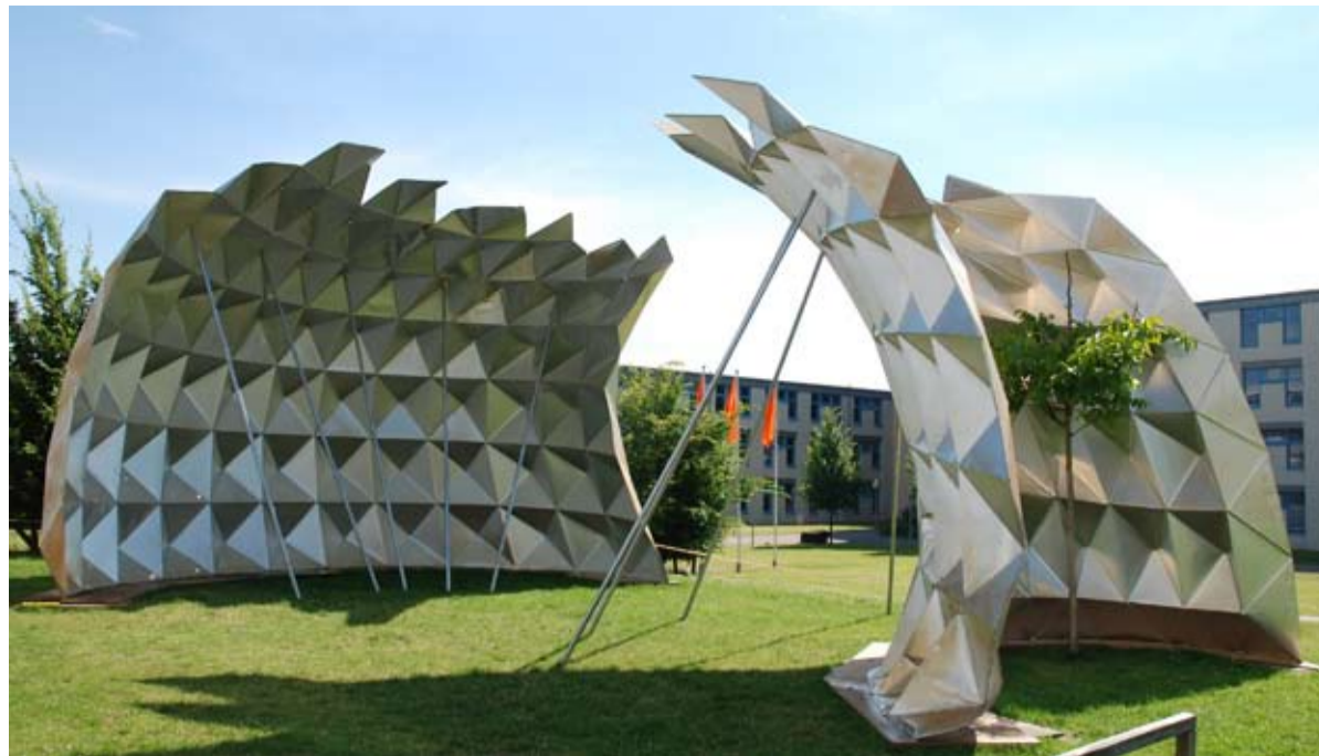
Aus dem Blobmaster-Kurs als praktische Arbeit entstanden: Das Raumfaltwerk vor dem Architekturgebäude besteht aus 800 Bauteilen aus Feinstblech.
