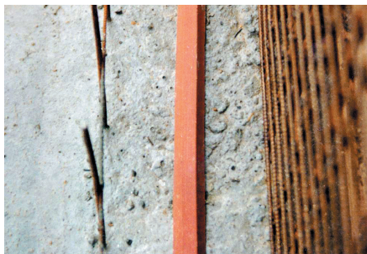
Bild 1: Arbeitsfuge mit quellfähiger Fugeneinlage
