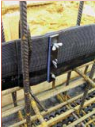
Bild 7: Geklemmter Stoß beim KAB 125 (vor Abschneiden der überstehenden Enden)
