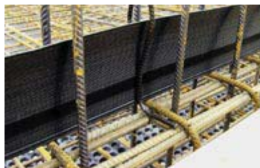
Bild 1: Kombi-Arbeitsfugenband KAB 125
