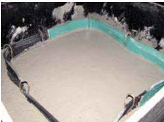
Bild 9: Montierter Arbeitsfugenbandring bestehend aus einem Flex Q 15 NB (grün) und einem A Q 15 NB (schwarz) nach dem Betonieren der Bodenplatte
