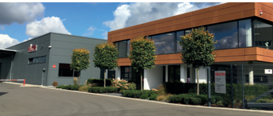
▲ Beispiel für einen aktuellen Gewerbebau mit vorgehängter hinterlüfteter Stahlfassade Foto: Thiemo Ebbert
