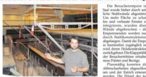
Komplexe Baustelle: Der Stadtsaal im Neuen Rathaus. Bauleiter Marc Thielmann erklärt, welche Arbeiten derzeit laufen und welche Herausforderungen zu meistern sind. Foto: Stadt Leipzig/ps
