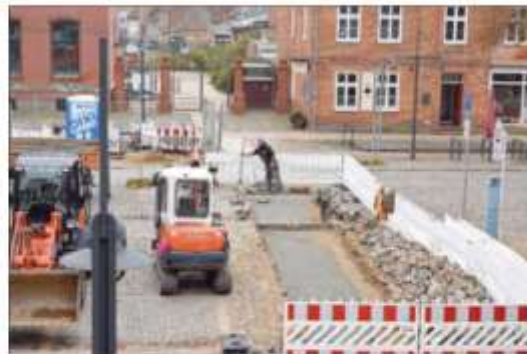
Die Bauarbeiten führten in der Schloßstraße nur zu geringen Einschränkungen im Straßenverkehr Fotos: Sylvia Wegener
