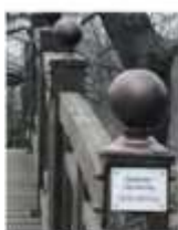
Die neue Geländeverzierung ist aus Kunststoff in Metalloptik gefertigt. Foto: Stadt Leipzig
