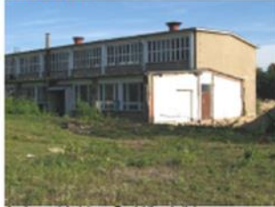
Am Lagerplatz (ehem. Produktionshalle)
