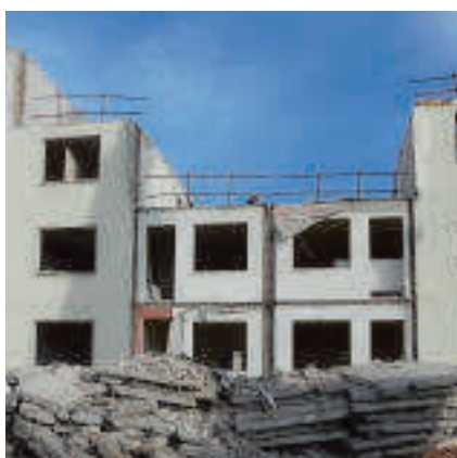
Entkernung und Rückbau von Etagen sowie Anbau eines Eckturmes am Mehrgenerationenhaus
