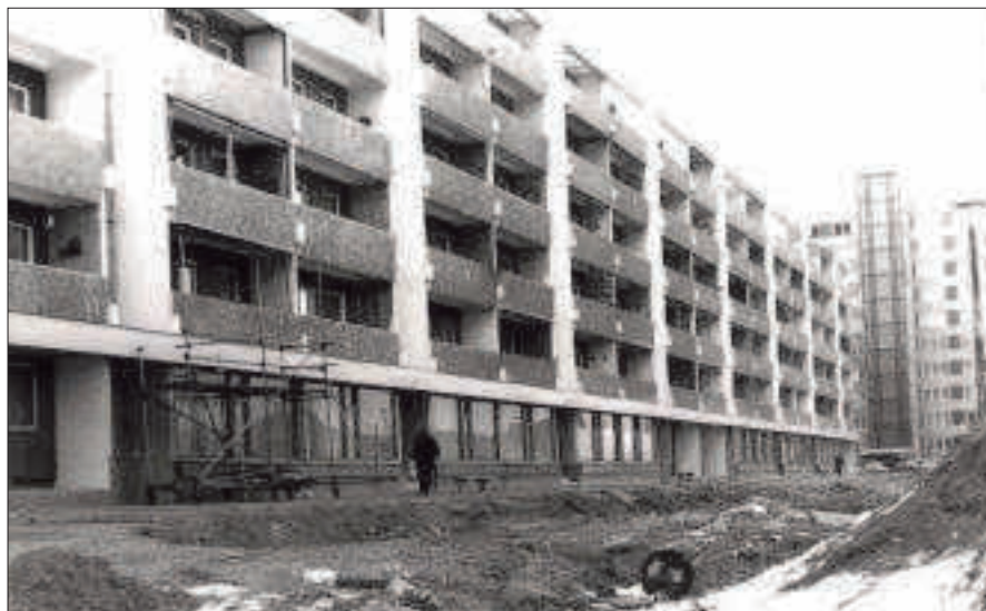
Bau der Ladenzeile an der Lindenauer Straße, damals Hermann-Duncker-Straße
