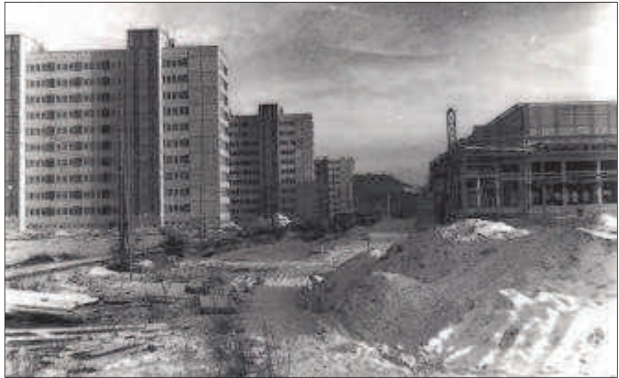
Hochhäuser an der Straßenbahntrasse und im Bau befindliche Kaufhalle
