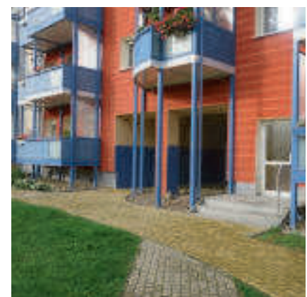
Neuer Durchgang zur Löbnitzstraße anstelle einer Erdgeschosswohnung
