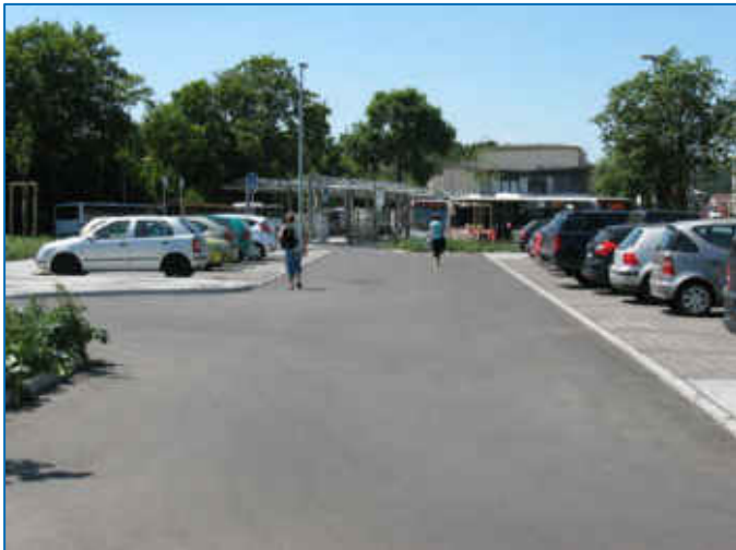
Foto 8: Park+Ride-Anlage am Bahnhof/ ZOB Meißen nach erfolgtem Ausbau und Erweiterung 2014, Foto: ISUP
