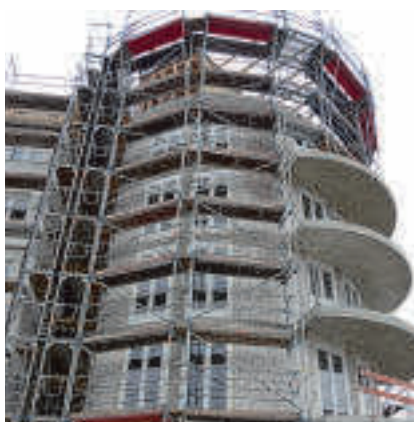
Entkernung und Rückbau von Etagen sowie Anbau eines Eckturmes am Mehrgenerationenhaus
