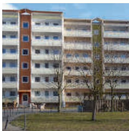
An der Breiten Straße 6 und 8 wurde durch Rückbau zweier Aufgänge ein Durchbruch durch die etwa 250 m lange Gebäudezeile geschaffen.
