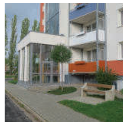
Barrierefreier Zugang zum Hochhaus Am Ringpark mit Sitzbank
