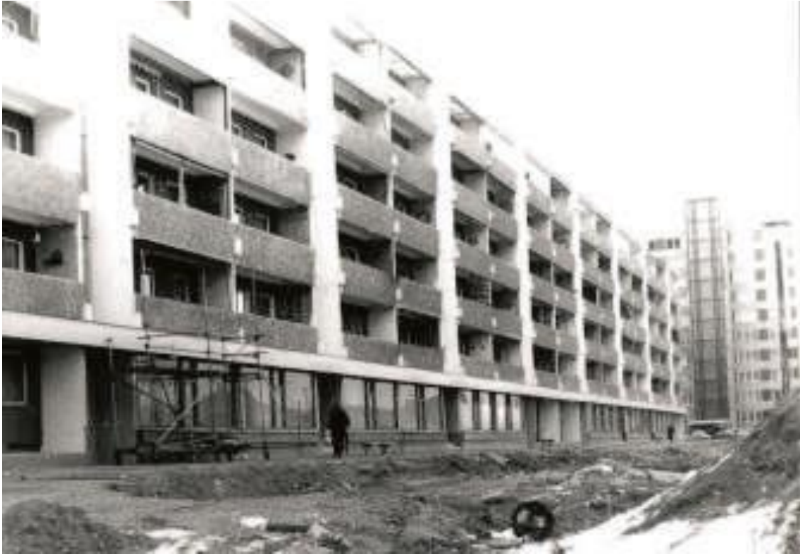
Abbildung 10 Bau der Ladenzeile an der Lindenauer Straße, damals Hermann-Duncker-Straße 64
