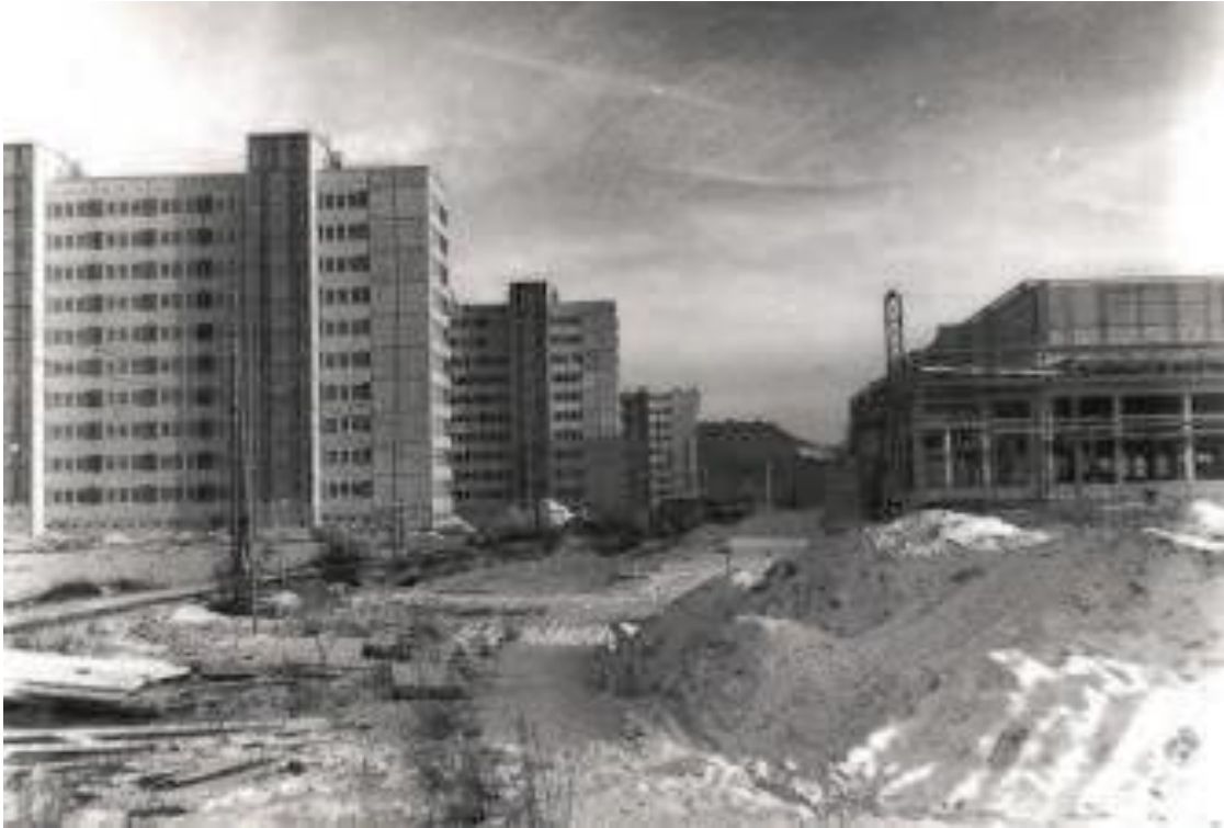
Abbildung 7 Hochhäuser an der Straßenbahntrasse und im Bau befindliche Kaufhalle 59
