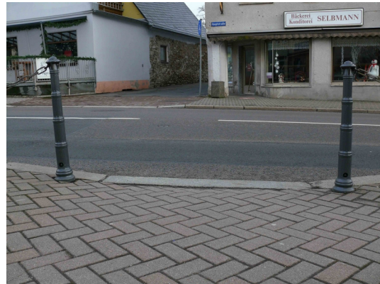
Fotografie 2: Zwei gegenüberliegende abgesenkte Bordsteine
