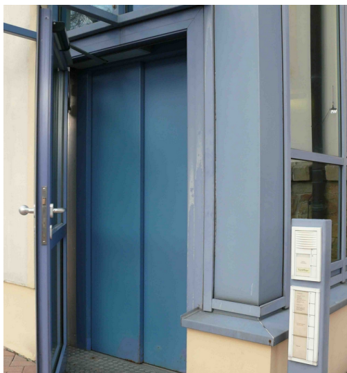
Fotografie 35: Eingang Stadthaus - Aufzug geöffnet
