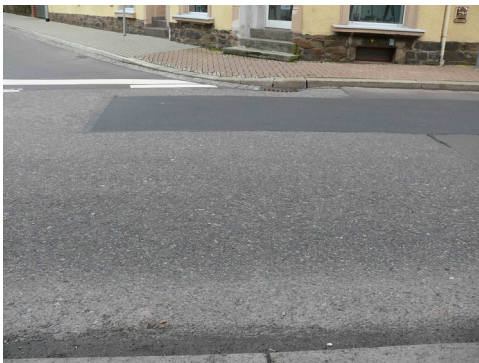
Fotografie 3: Einseitig abgesenkter Bordstein Bahnhofstraße
