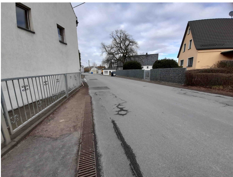
Fotografie 19: Kein Gehweg vorhanden
