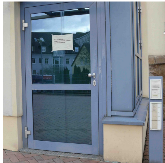
Fotografie 36: Eingang Aufzug geschlossen
