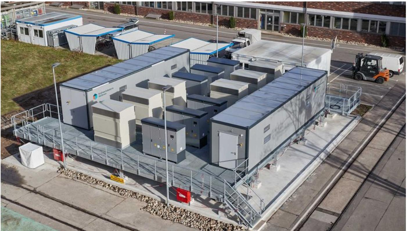
Gemeinsam mit Bosch hat die EnBW im Kraftwerk Heilbronn eine neue Kraftwerksbatterie aus 768 Lithium-Ionen-Batterien aufgebaut. Der Batteriespeicher verfügt über eine maximale Leistungsabgabe von rund fünf MW mit einer installierten Speicherkapazität von fünf MWh. [Bild herunterladen](#)
