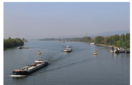
Frachtschiffe fahren in die Baustelle der Schiersteiner Brücke bei Wiesbaden, die passierbare Fahrstrecke ist mit Wahr­schauflößen gekennzeichnet
