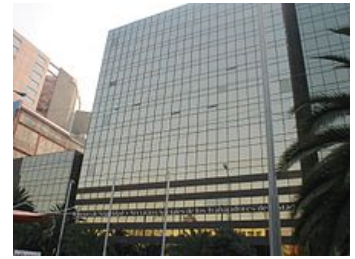
Zentrale der ISSSTE, Mexiko-Stadt
