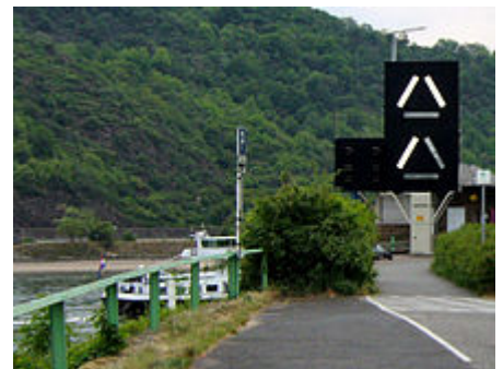
Signalstelle E „An der Bank“ bei St. Goar für die Bergfahrt
