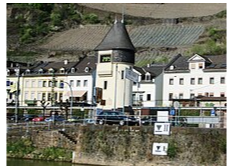
Pegel Kaub mit Pegelturm und Hochwassermarken
