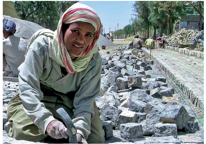
Der Bau kommunaler Pflastersteinstraßen schafft lokale Erwerbsmöglichkeiten in Äthiopien.
