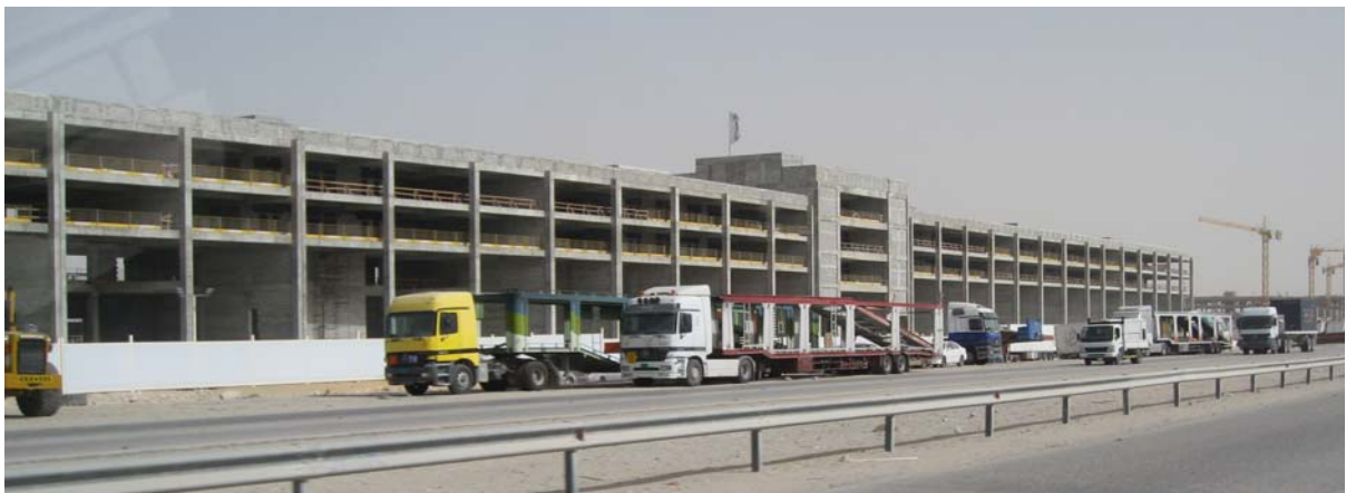
Bild 4: Teil des fertiggestellten Rohbaus von Type 4 der Barwa Commercial Avenue (Foto: Horst Werkle)
