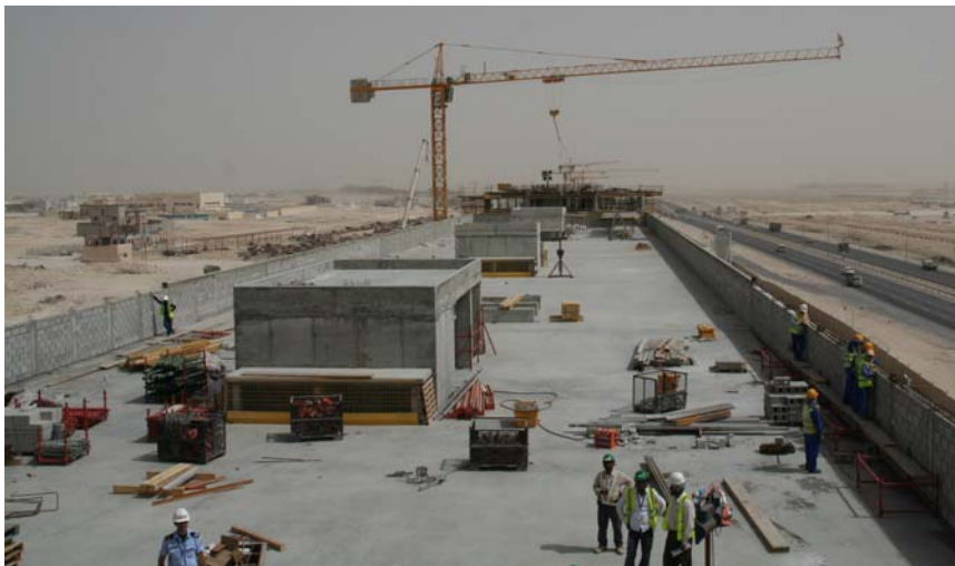
Bild 13: Blick auf einen Bauabschnitt (Foto: Horst Werkle)
