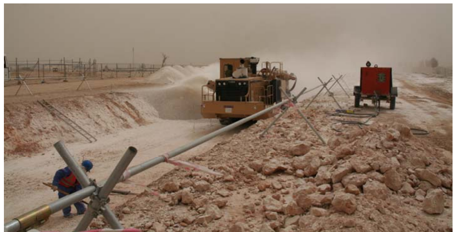
Bild 11: Trencher bei der Arbeit (Foto: Horst Werkle)
