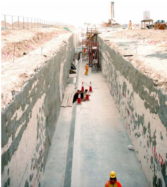
Bild 16: Ausgleich von Unebenheiten der Felswand (Foto: Philip Scherzinger)
