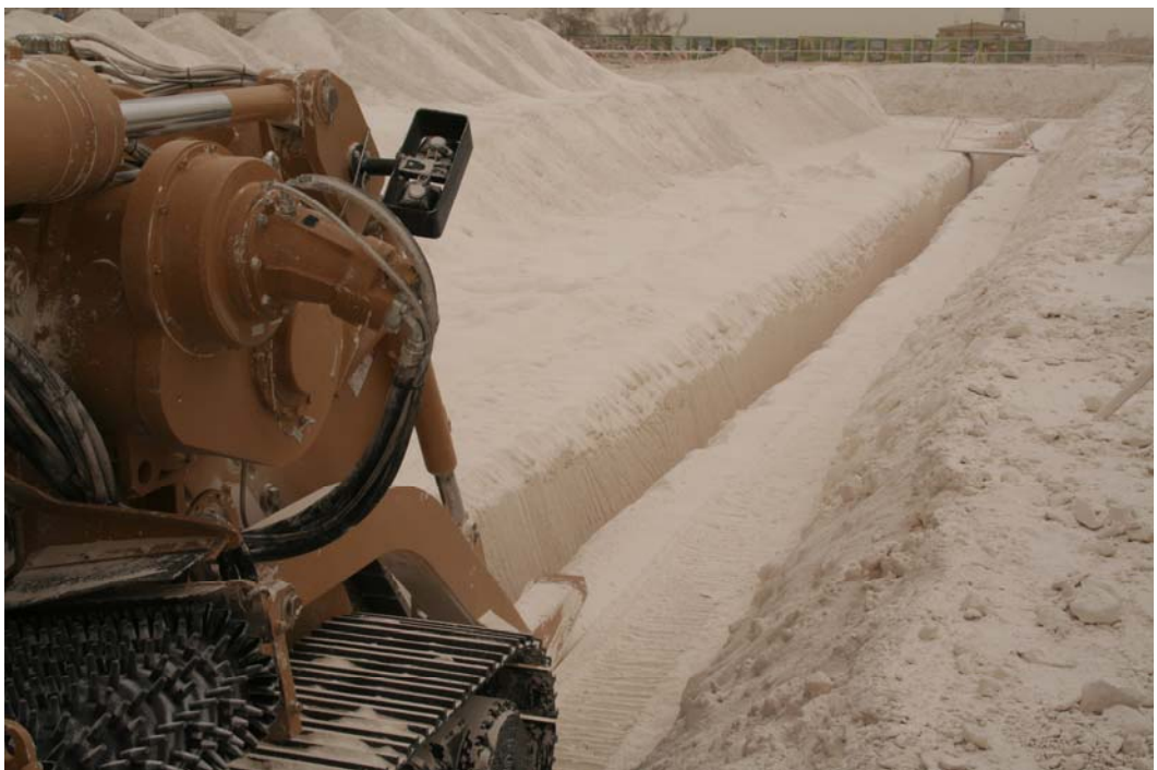
Bild 13: Fertiggestellter Schlitz (Foto: Horst Werkle)
