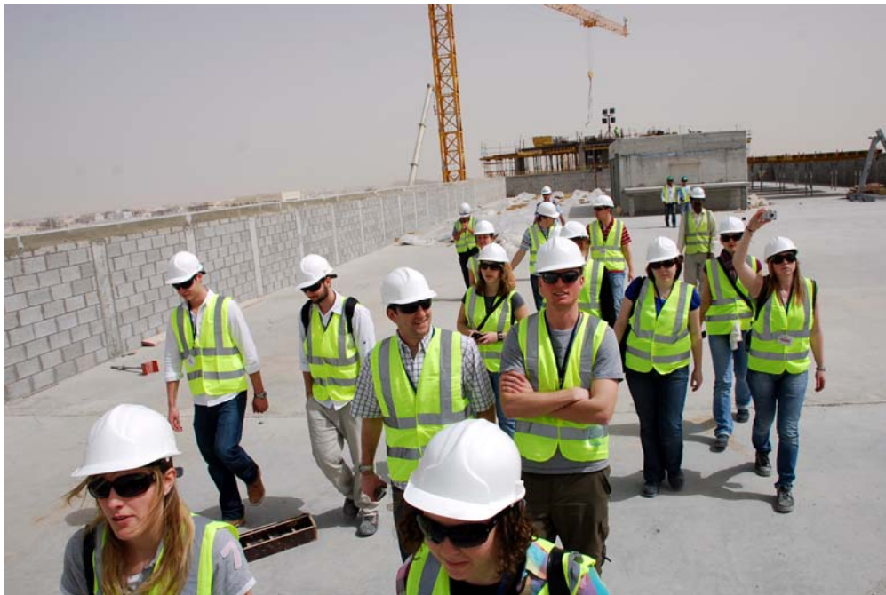
Bild 8: Gang über die Baustelle (Foto: Philip Scherzinger)
