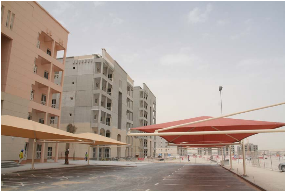
Bild 19: Erste fertiggestellte Gebäude (Foto: Horst Werkle)
