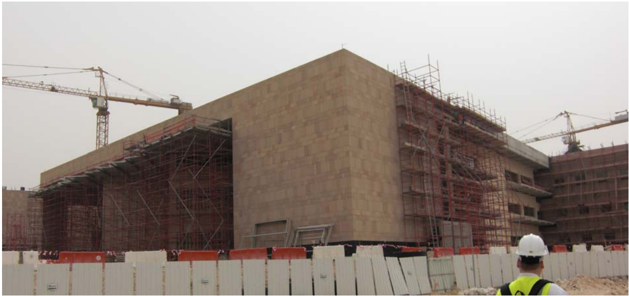
Bild 6: Blick auf eine Baustelle der Education City (Foto: Ines Bauer)
