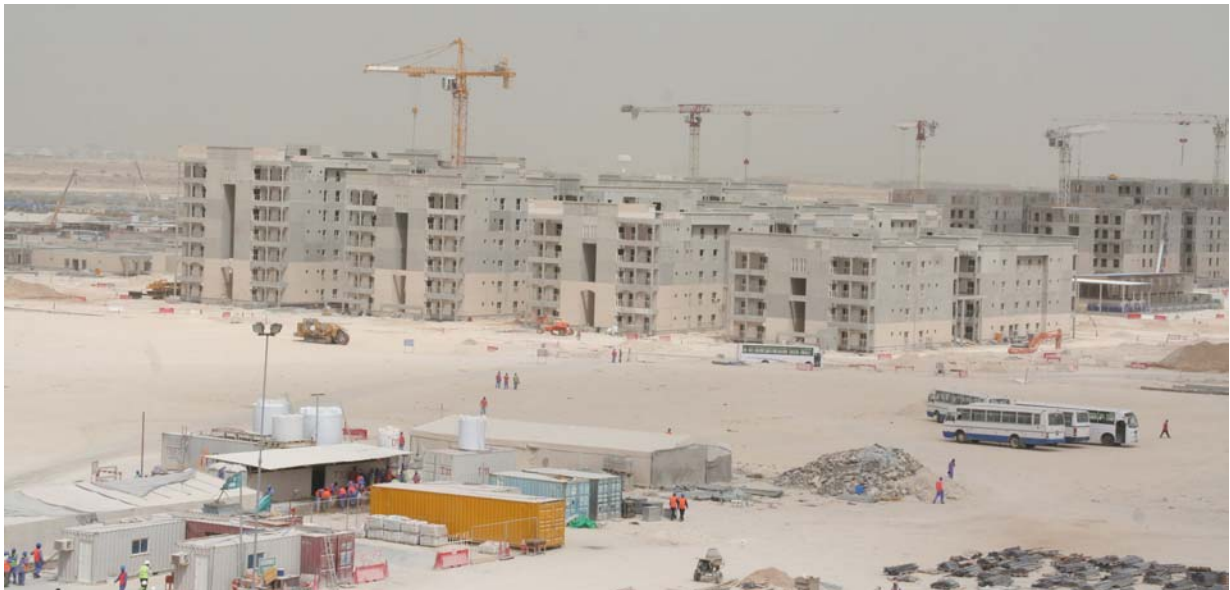
Bild 11: Blick über die Baustelle (Foto: Horst Werkle)
