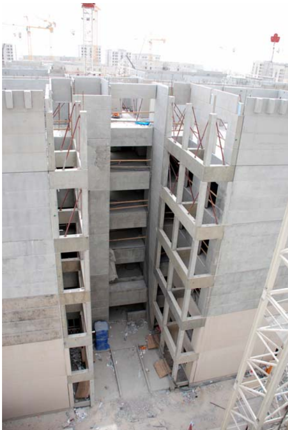
Bild 12: Fertigteil-Baustelle (Foto: Horst Werkle)
