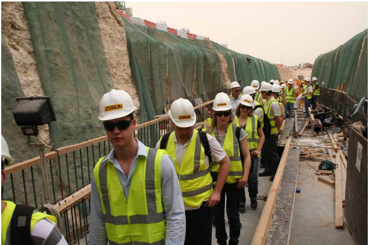
Bild 24: In der Baugrube (Foto: Horst Werkle)
