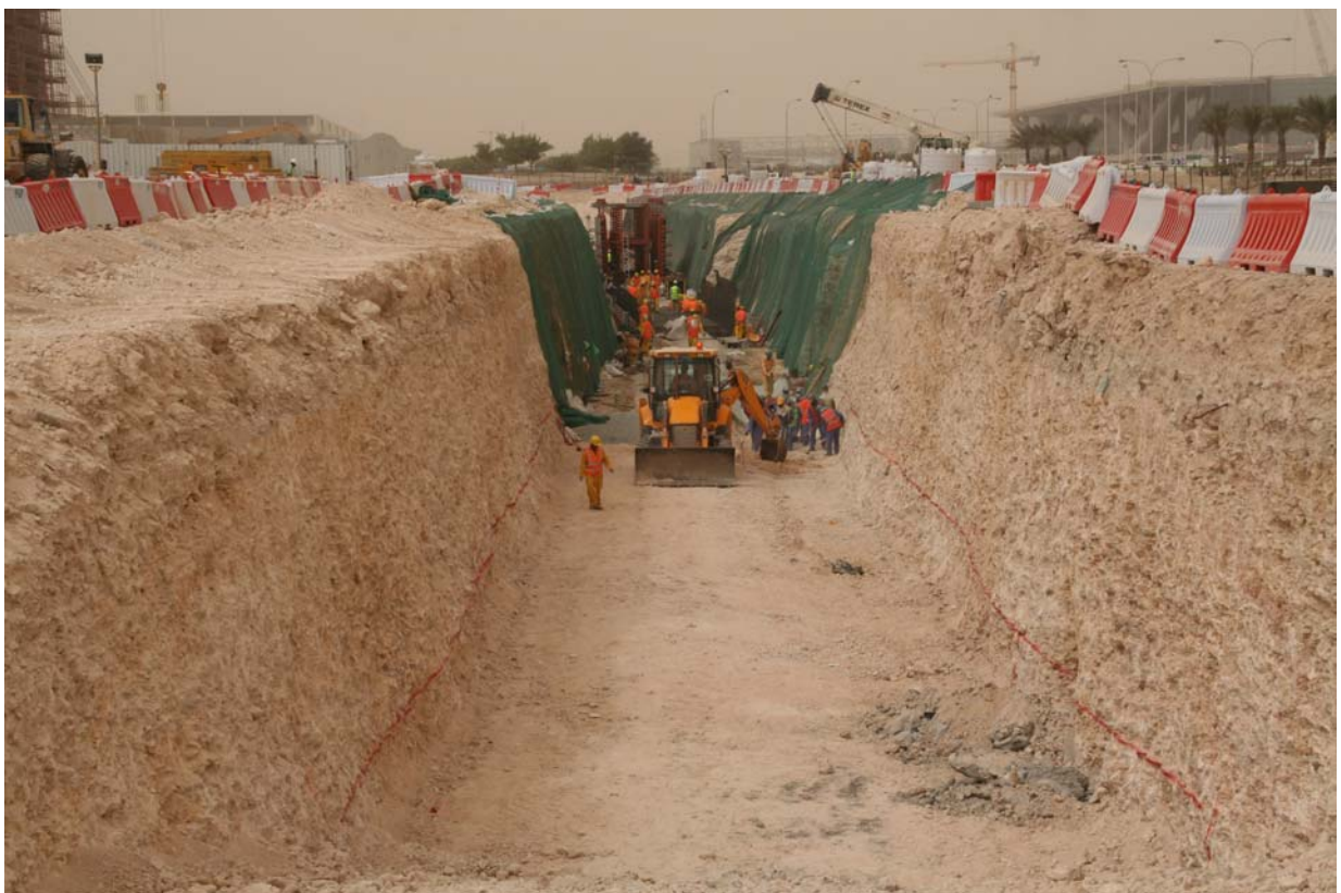
Bild 15: Blick in die Baugrube (Foto: Horst Werkle)
