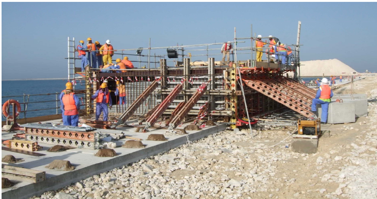
Bild 10: Schalungsarbeiten an einer Kaimauer (Foto: RLC)
