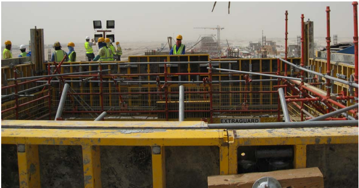
Bild 12: Schalungsarbeiten (Foto: Klaus-Peter Meßmer)
