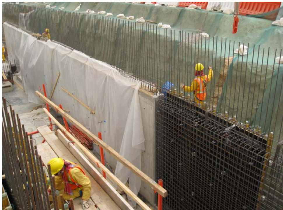
Bild 23: Wandbewehrung (Foto: Klaus-Peter Meßmer)
