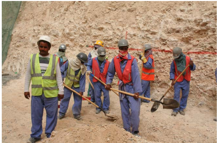
Bild 8: Arbeiter auf der Baustelle (Foto: Horst Werkle)
