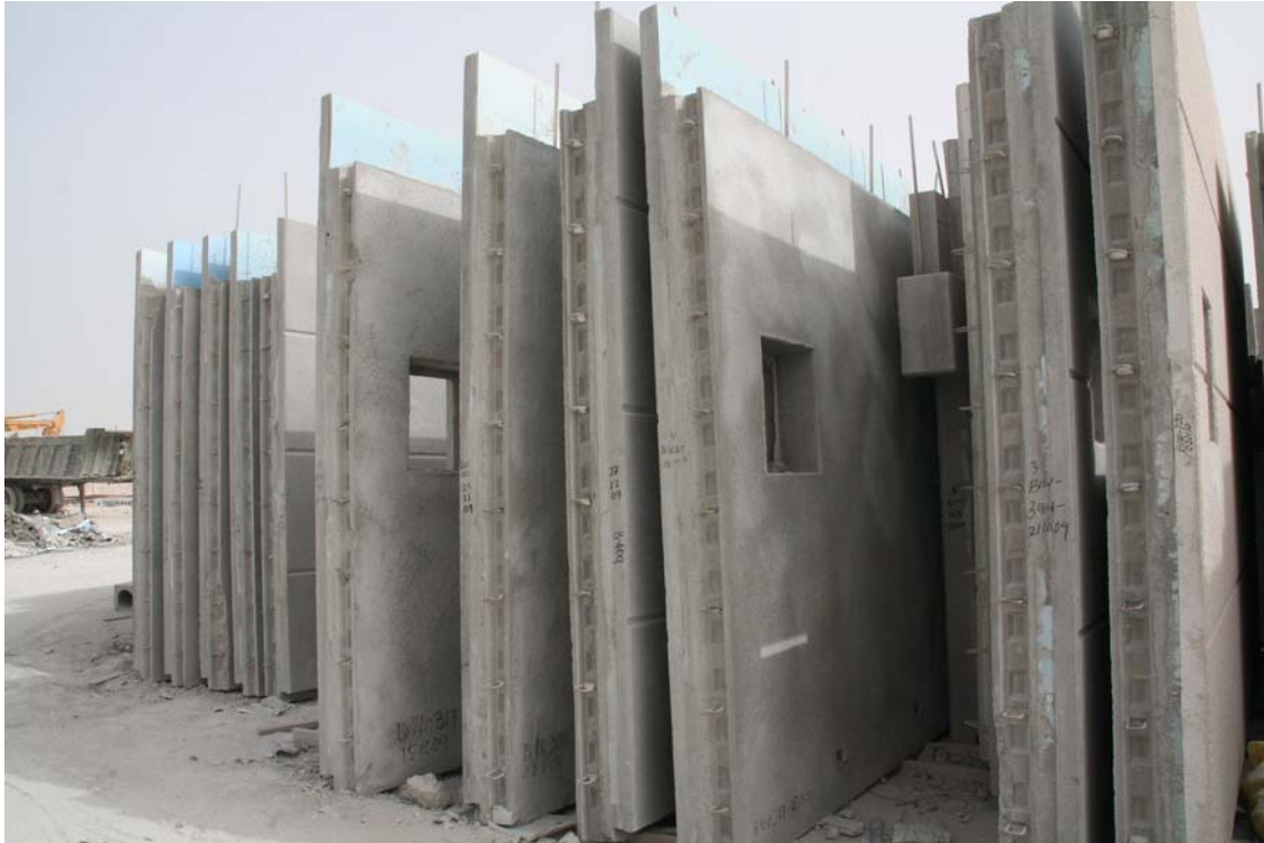
Bild 10: Lagerung von Wand-Fertigteilen (Foto: Horst Werkle)
