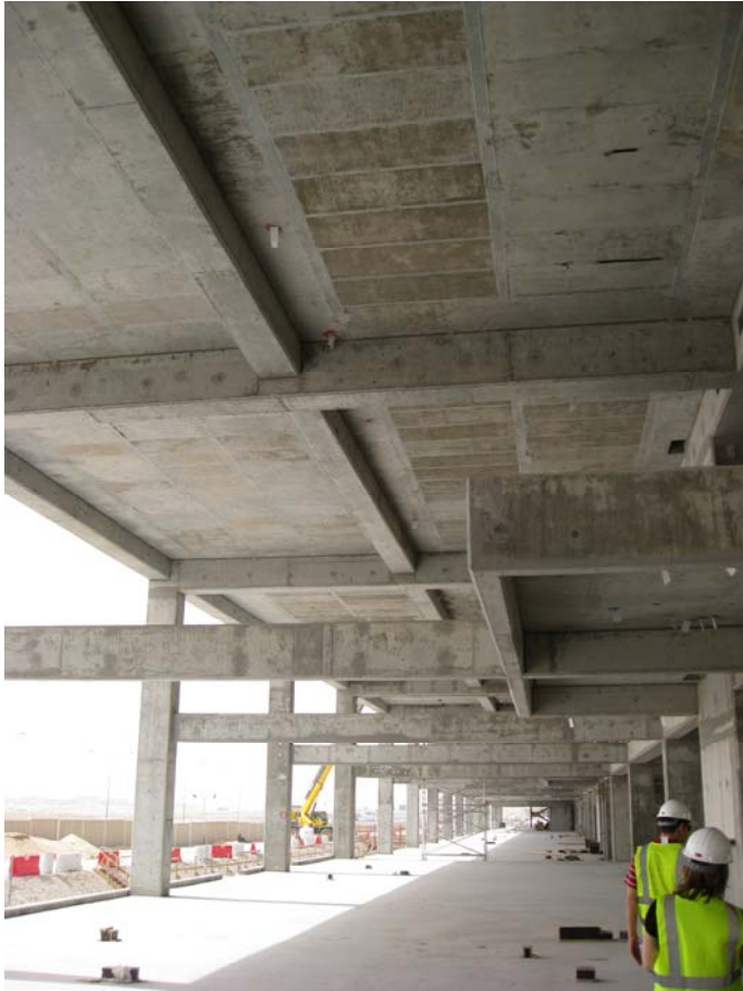
Bild 16: Fertiggestellter Rohbau Type 3 (Foto: Klaus-Peter Meßmer)
