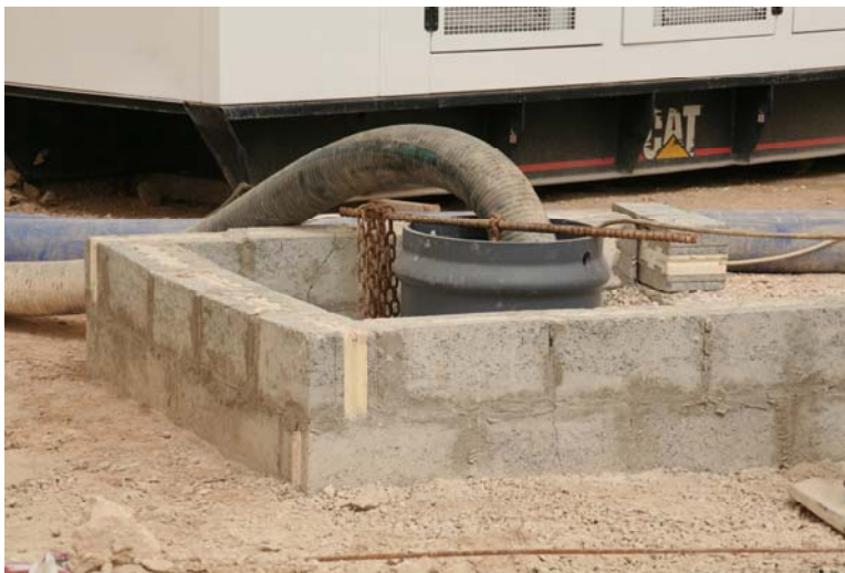
Bild 9: Pumpe für die Grundwasserabsenkung (Foto: Horst Werkle)
