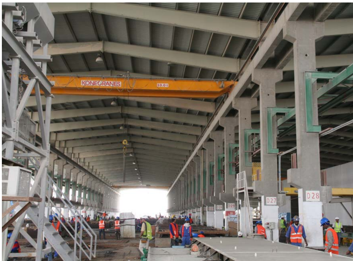
Bild 8: Im Fertigteilwerk (Foto: Horst Werkle)
