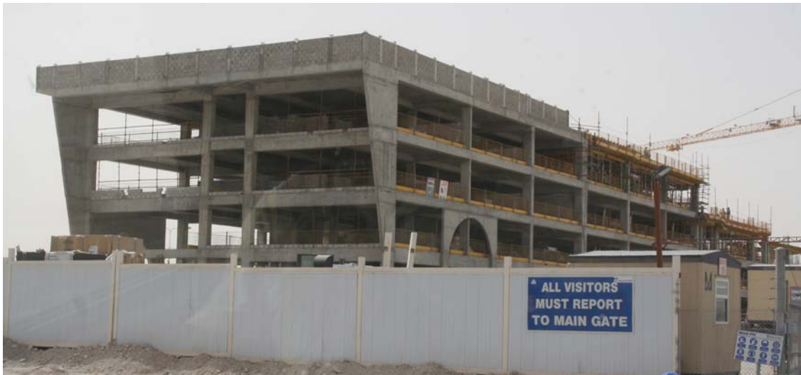
Bild 18: Rohbauabschnitt (Foto: Horst Werkle)
