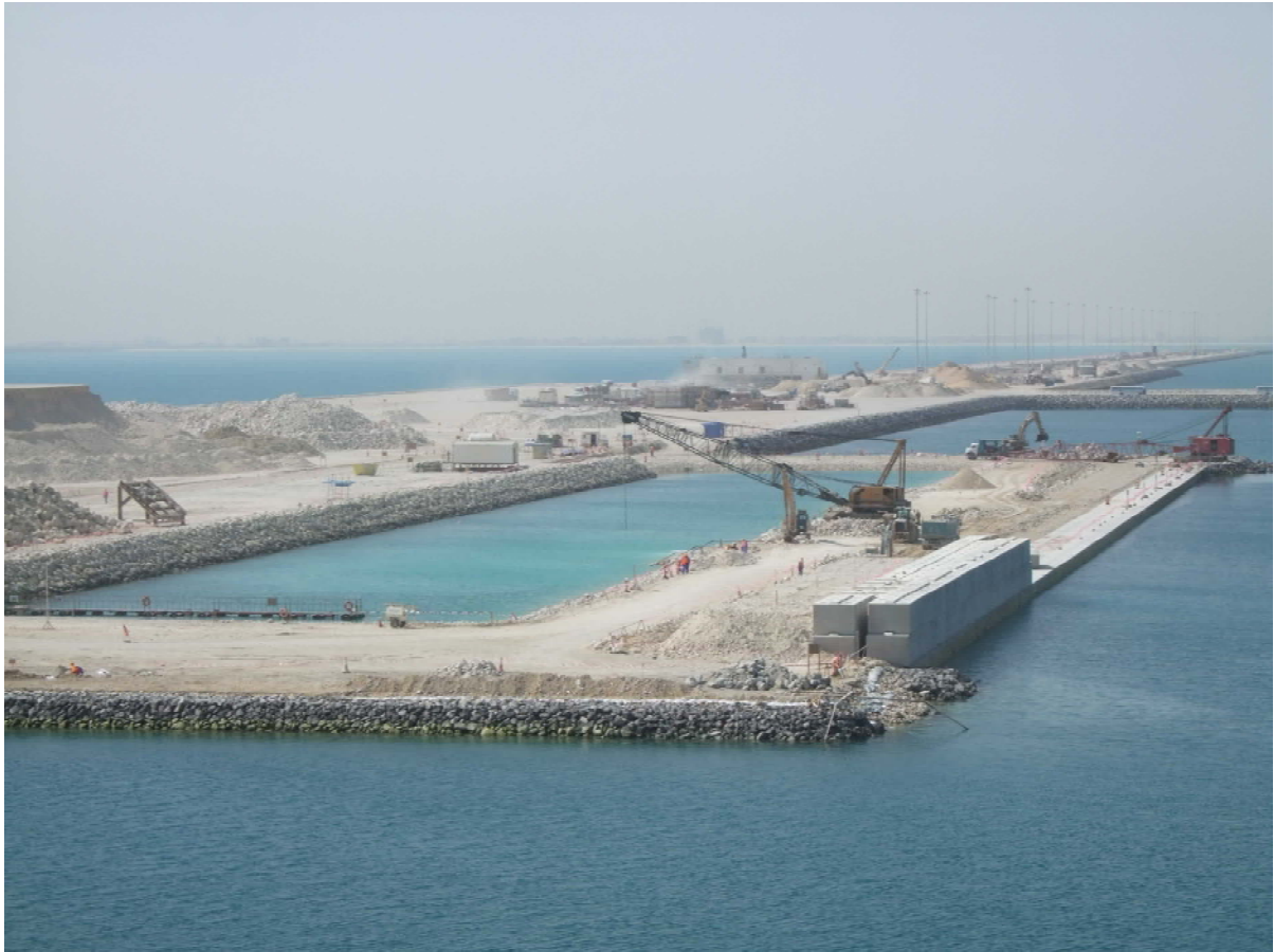
Bild 9: Hafengebäudearbeiten (Foto: CCC)
