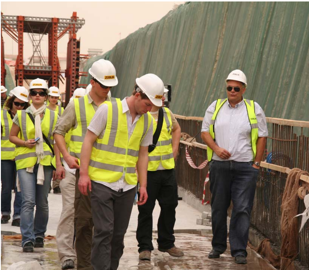
Bild 26: Mit Herrn Pötzsch auf der Baustelle (Foto: Horst Werkle)
