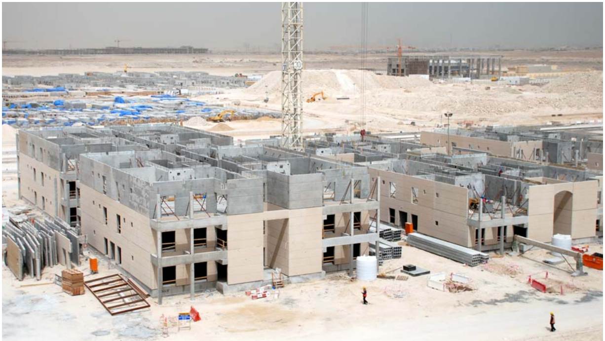
Bild 13: Montage von Fertigteilen mit dem Kran (Foto: Philip Scherzinger)
